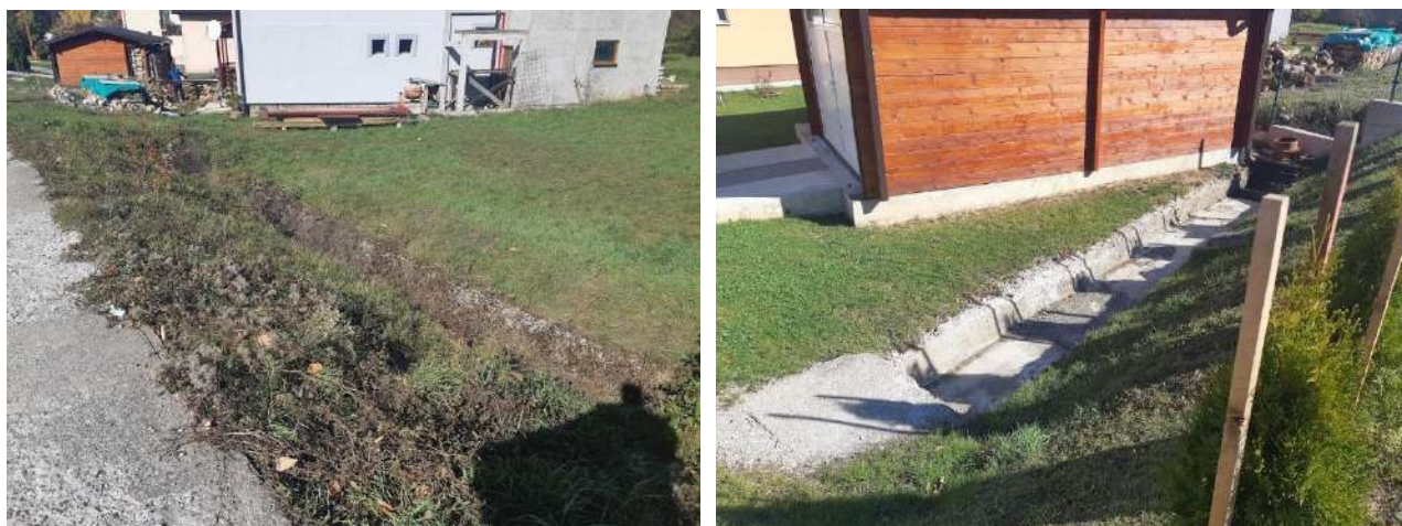
Slike 5 i 6: Kanal za pribrežne vode na uzvodnom i nizvodnom dijelu trase (nastavak kanala je uglavnom zatvoren ispod pristupnih puteva ka objektima)
