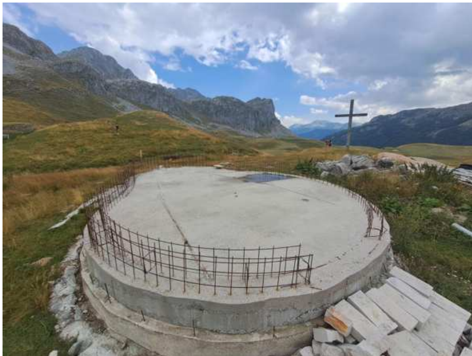
Slika 61 Temelji crkve Sv.Cara Lazara na Lukovici
