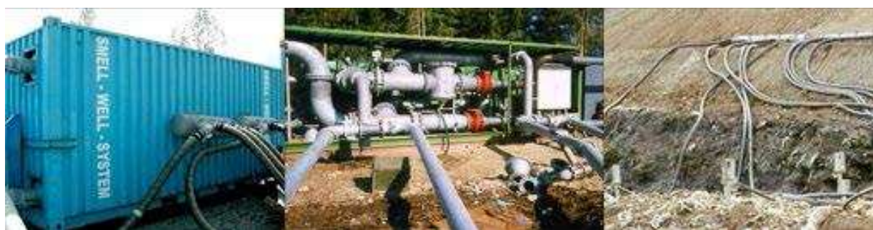
Slika 13: Izgled opreme u radu: Kontejner sa biofilterom (levo) - Priključak instalacije biofiltera (u sredini) - Cevni razvod na deponiji (desno)
