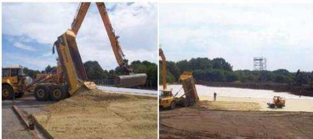
Slika 6 i 7: Način ugradnje trisoplasta
