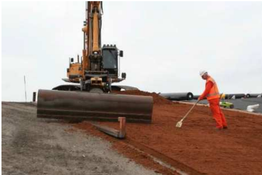
Slika 9: Razastiranje Trisoplasta i provera debljine sloja pre sabijanja
