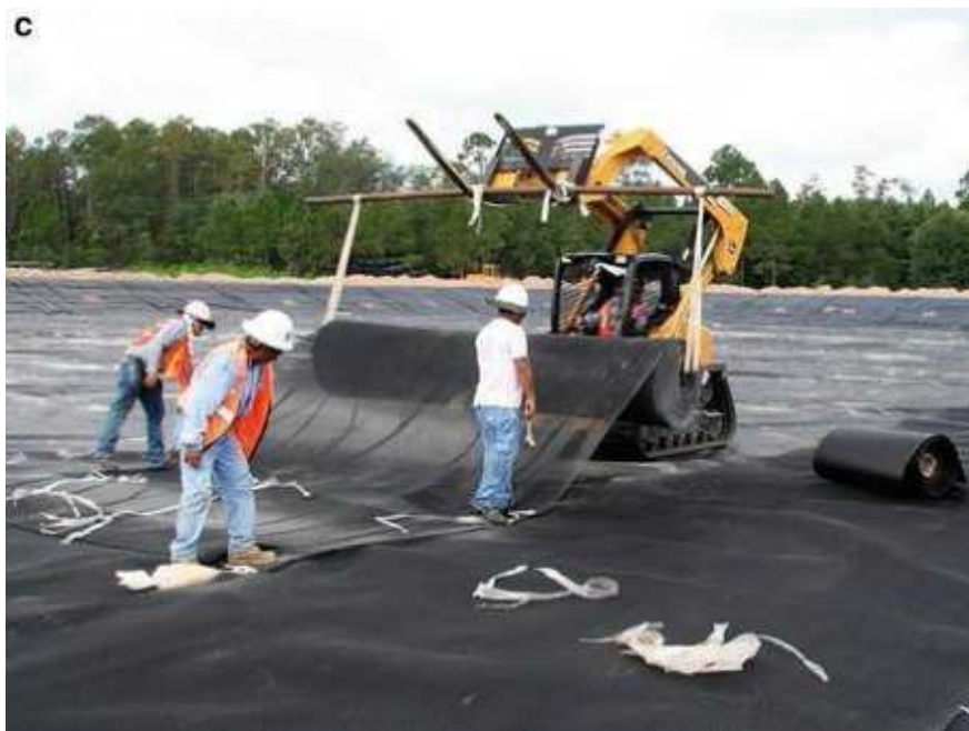
Slika 10: Detalj ugradnje geomembrane
