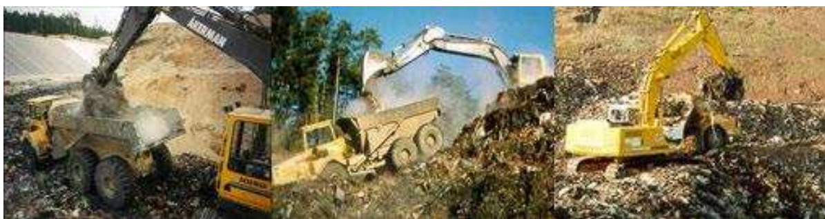
Slika 14: Iskopavanje stabilizovanog tijela deponije
