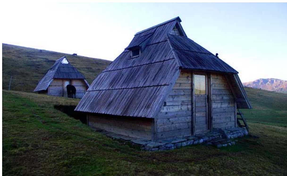
a) Tradicionalni arhitektonski izraz – zasječeni krovovi na zabatu
